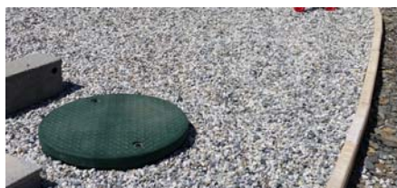
Tampon de \varnothing 60 cm verrouillable donnant accès au coffret abritant le surpresseur d'air et le programmeur
