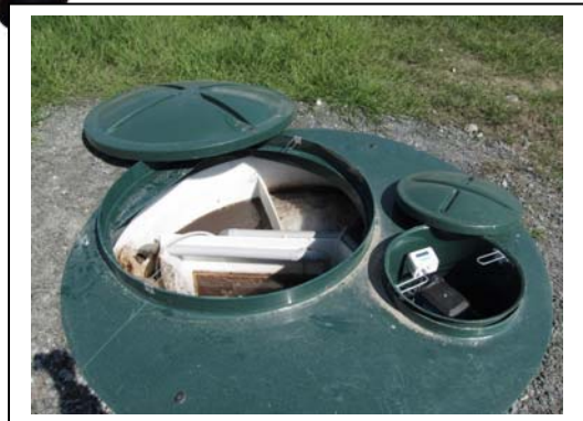
Coffret interne intégré amovible pour surpresseur d'air et boîtier de commande
